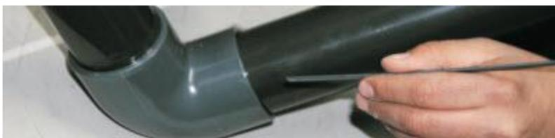
С целью повышения надежности соединения, до сварки можно нанести на соединяемую поверхность в области муфты клей. Данный метод, называемый методом скрытого склеивания, следует выполнять так, чтобы клеящее средство никоим образом не находилось на точка сварки.
